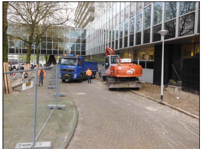
Foto 14: ontgraven herbruikbare grond
