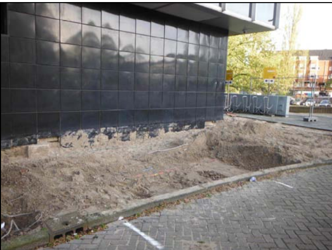
Foto 9: situatie na verwijderen sterk verontreinigde grond
