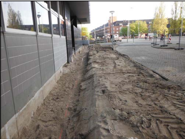
Foto 7: situatie na verwijderen sterk verontreinigde grond
