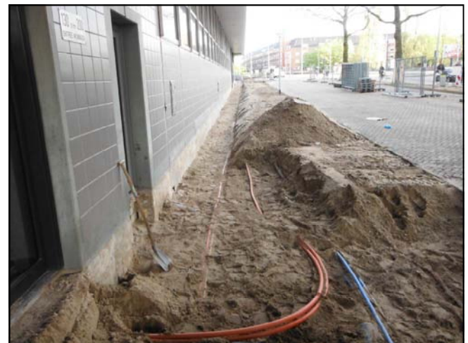
Foto 6: situatie na verwijderen sterk verontreinigde grond
