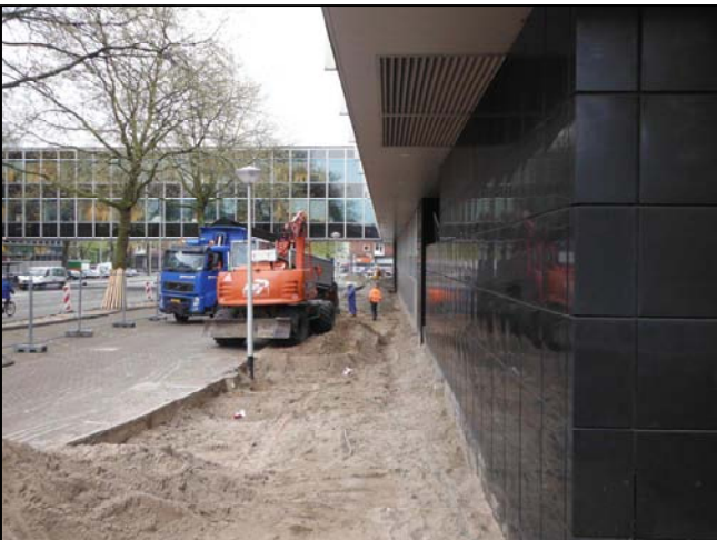
Foto 15: ontgraven herbruikbare grond
