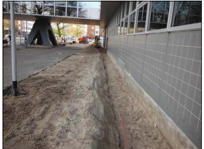
Foto 8: situatie na verwijderen sterk verontreinigde grond
