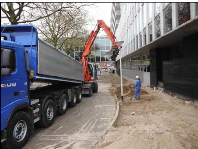
Foto 17: ontgraven herbruikbare grond
