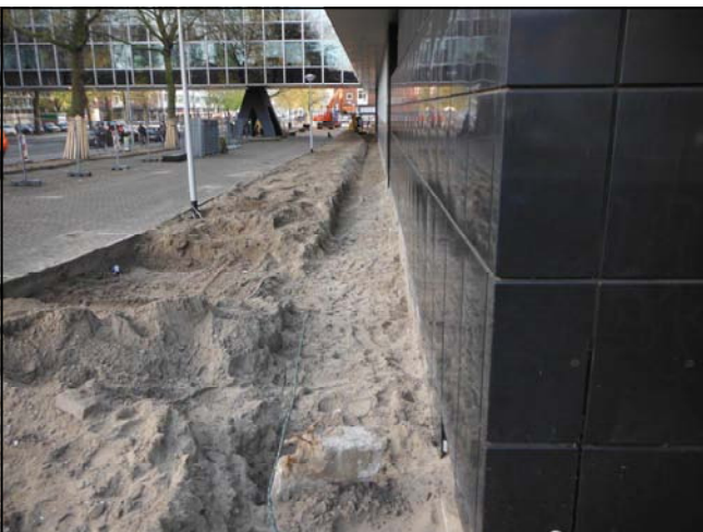
Foto 10: situatie na verwijderen sterk verontreinigde grond
