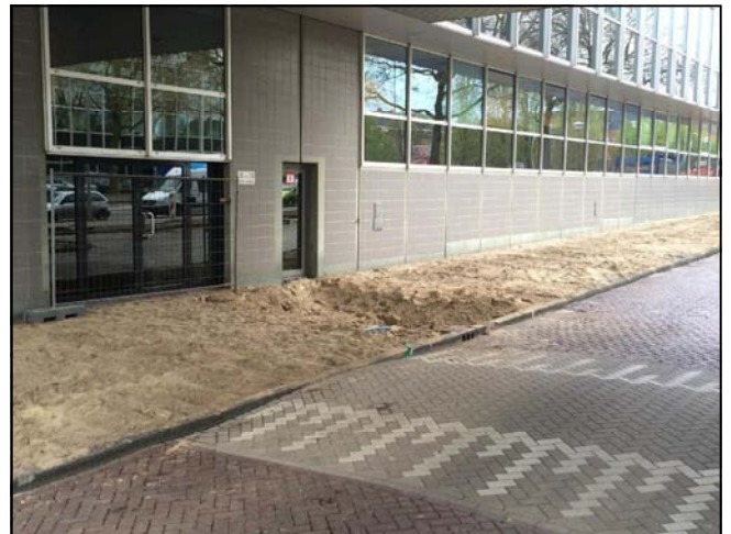
Foto 4: verwijderen hotspot PCB
