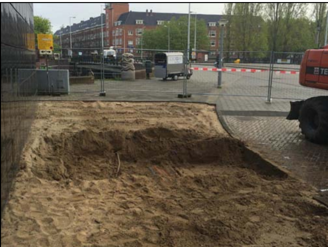
Foto 3: verwijderen hotspot PCB
