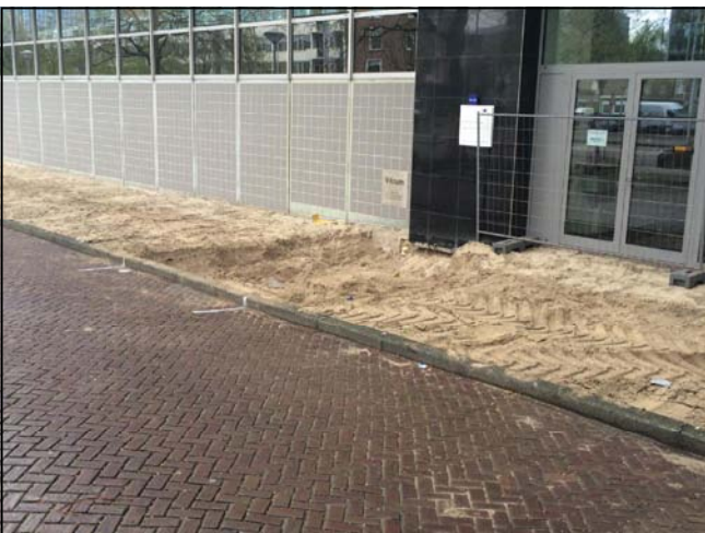
Foto 5: verwijderen hotspot PCB
